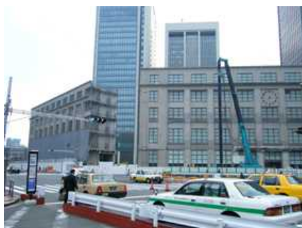
図1.解体中の中央郵便局(千代田区)
